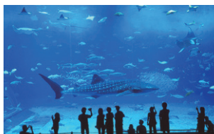
使用甲基丙烯酸酯树脂制造的水族馆内大型水槽
