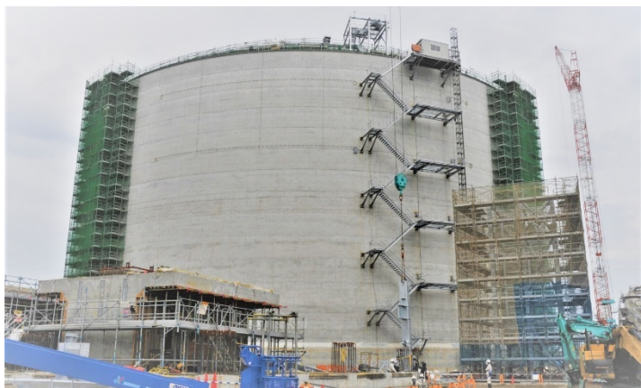
愛媛工場敷地内に、国内最大級のLNGタンクを建設中
